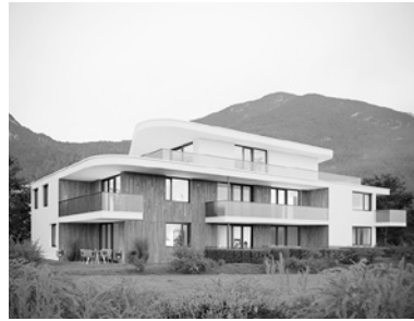
Foto: Kraft - Werk Architektur
