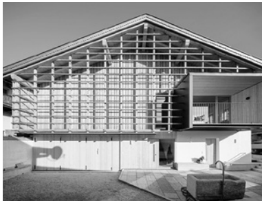
Foto: Günter Dirr, zquadrat, Huter & Söhne, Holzbau
